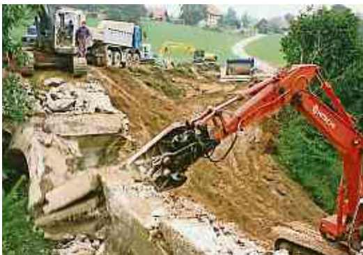
Abbruch Eisenbahnbrücke Tobel 1993
