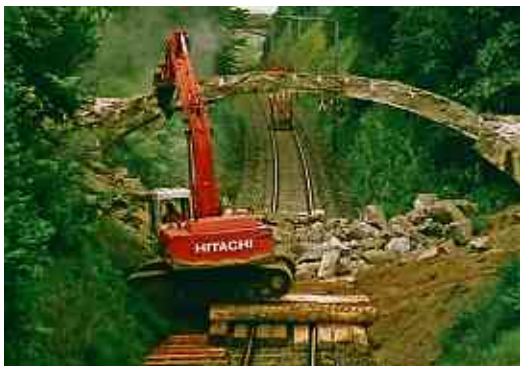
Abbruch Eisenbahnbrücke Tobel
