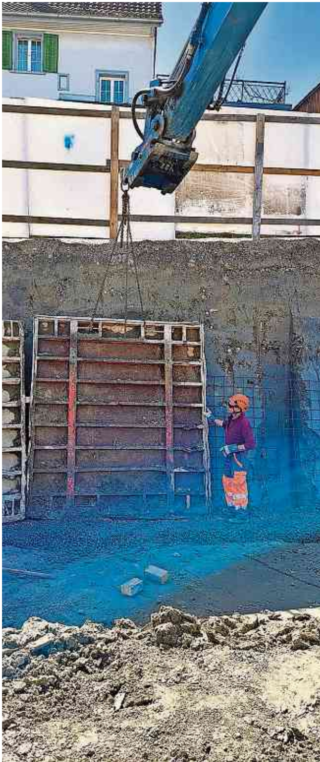
Tiefbau MFH Rothenhausen
