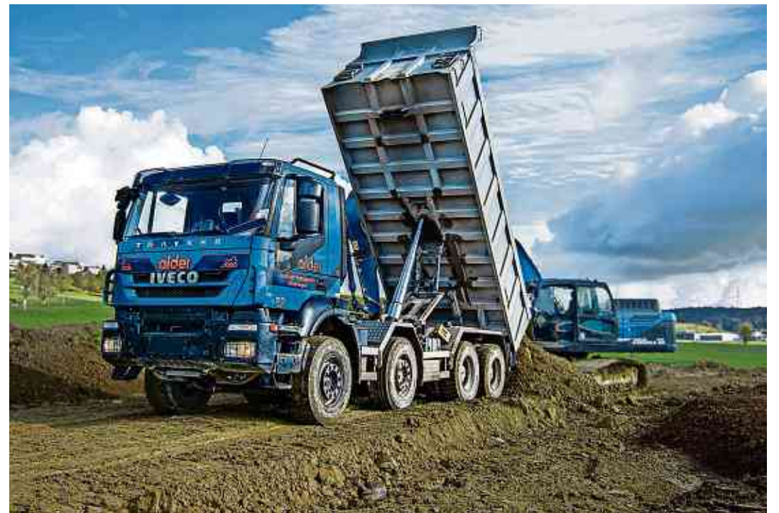
Aushub wird von der Baustelle zur Deponie befördert
