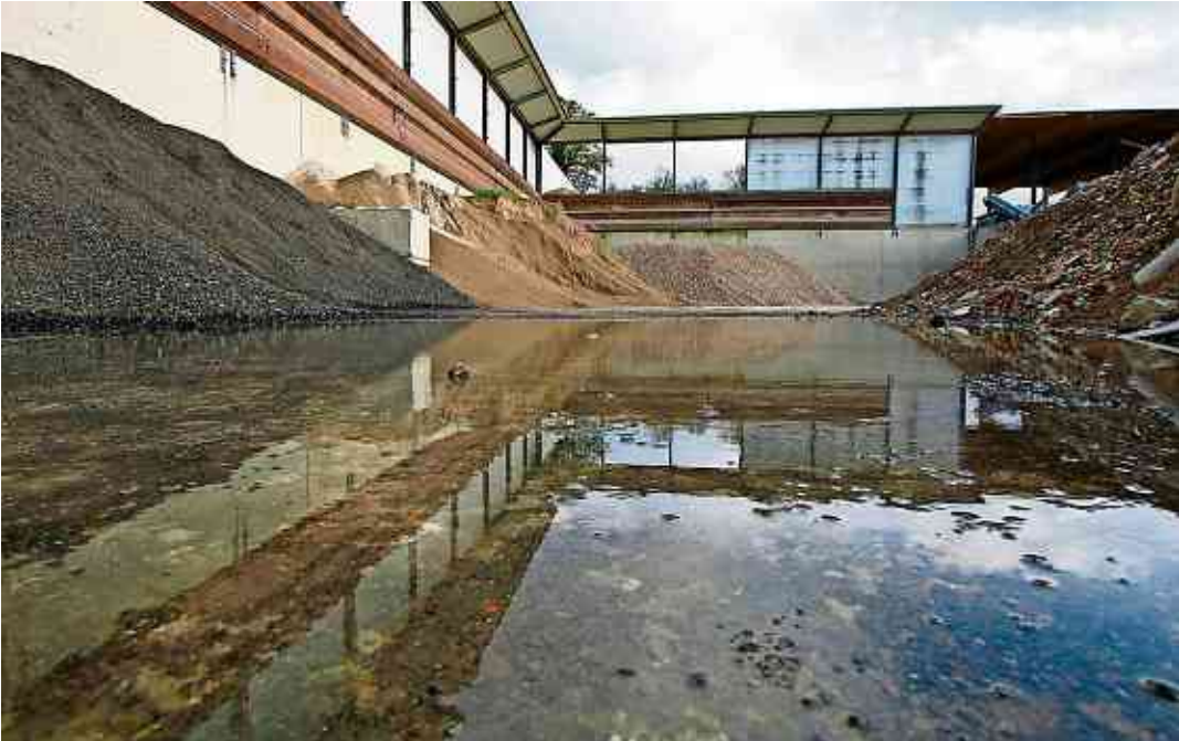
Bauschutt aus Ausbaupasphalt, Strassenaufbruch, Betonabbruch und Mischabbruch wird zur Wiederverwendung verkleinert.
