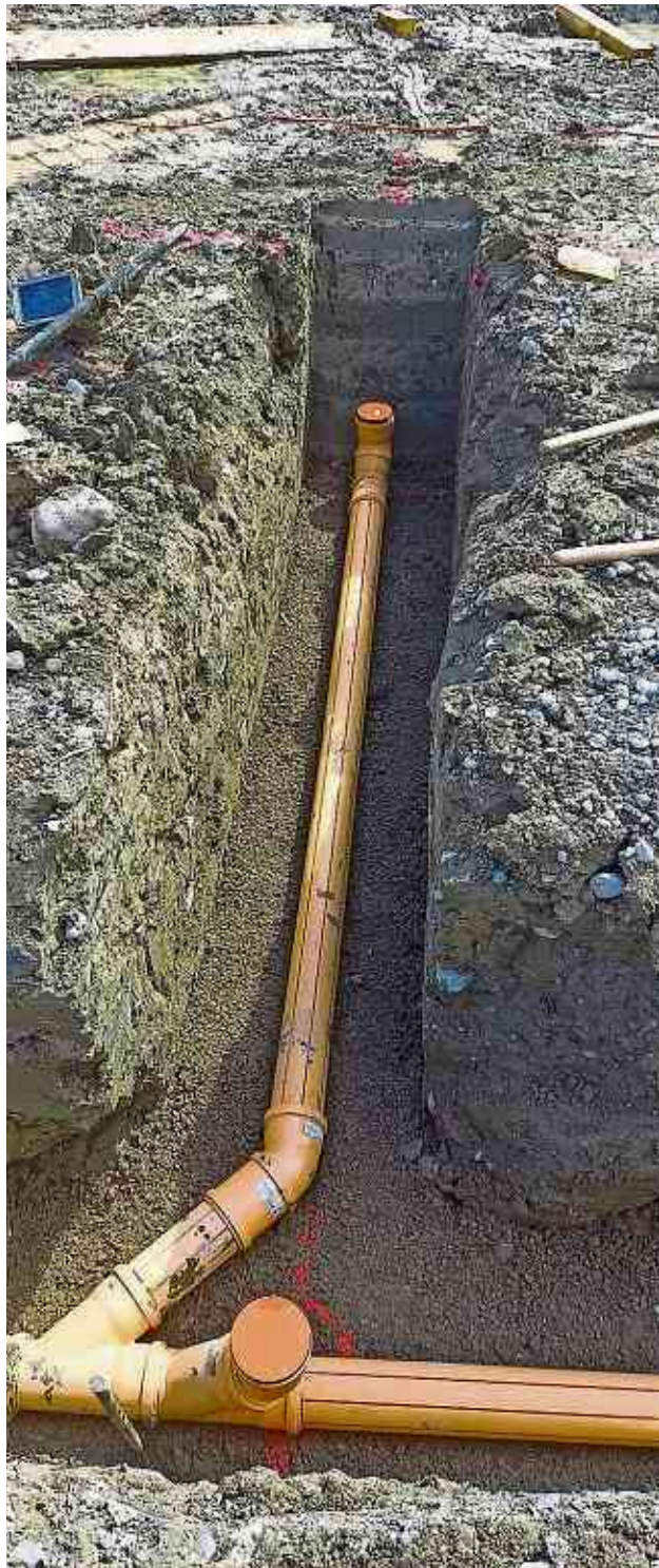
Leitungsbau MFH Rothenhausen
