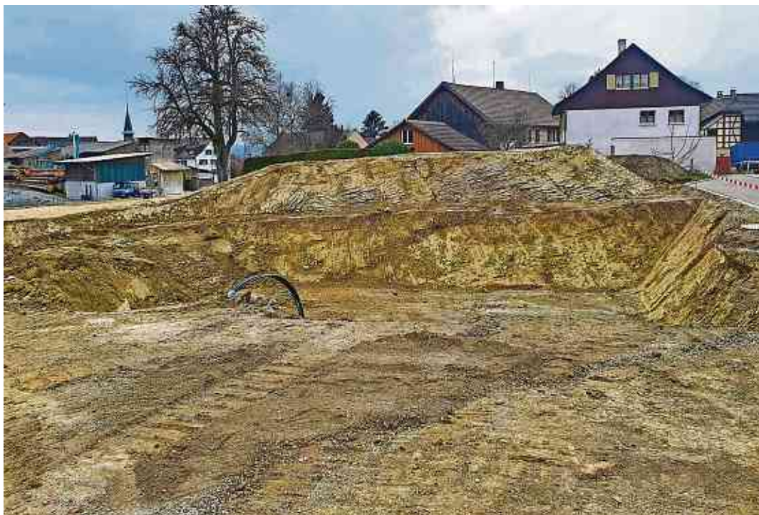
Erdbau EFH Raperswilen
