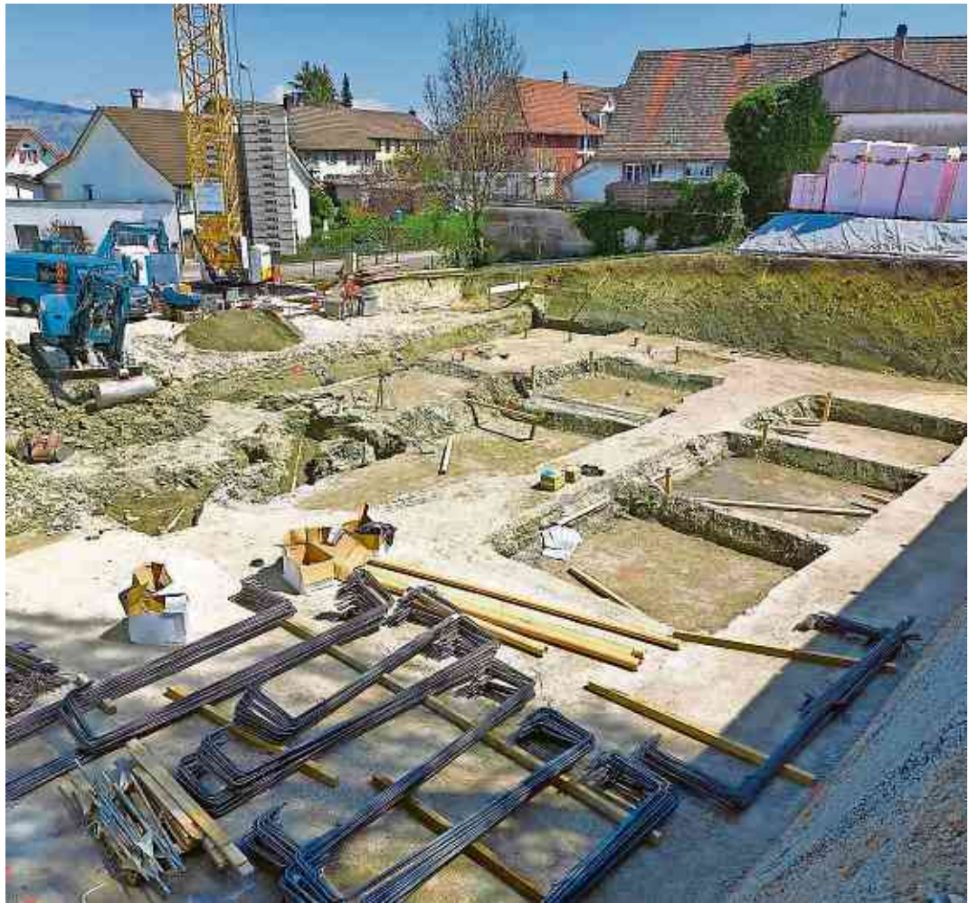
Tiefbau MFH Rothenhausen
