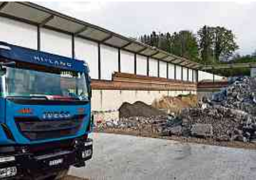
Flexibel und vielseitig – Bauschutt Deponie in Affeltrangen
