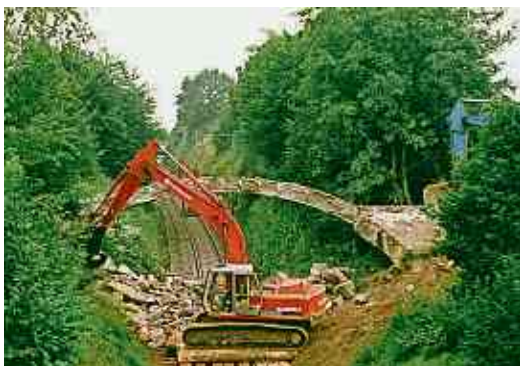
Abbruch Eisenbahnbrücke Tobel
