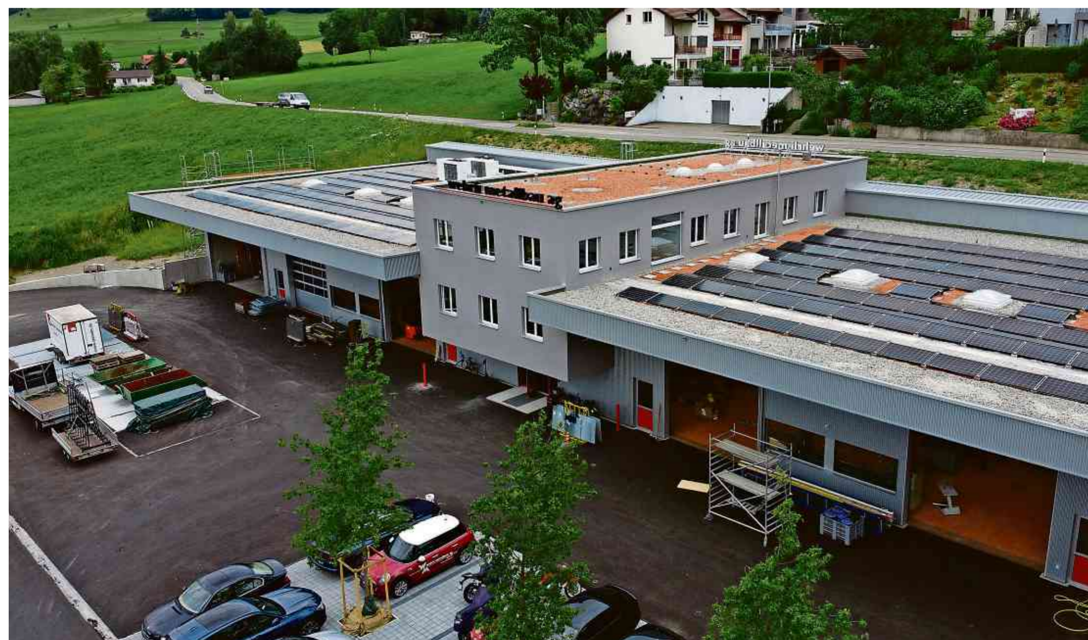
Ansicht Parkplatz Gebäude
