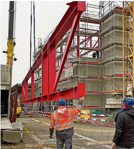
Tonnenweise Stahlträger und Armierungseisen wurden verbaut.
