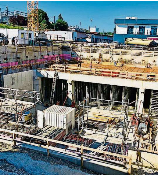
Für den Neubau war ein voluminöser und extrem aufwendiger Aushub nötig.
