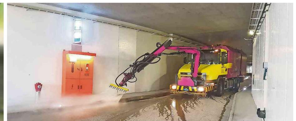
Strahlwasser mit zugesetzten Reinigungsmitteln werden mit bis zu sieben bar Druck eingesetzt. Elkuch-Anlagen halten das aus.
