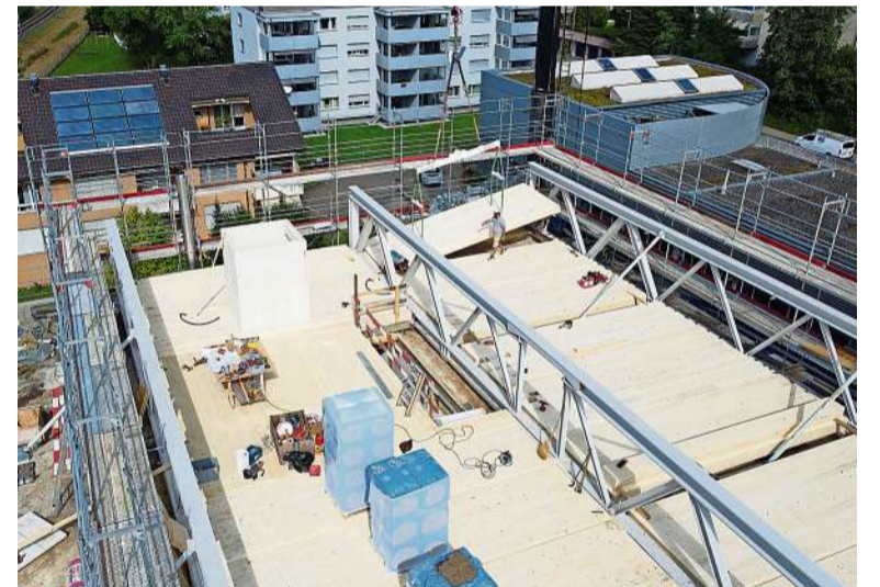
Hinten links ist bereits der Schacht für den Personenlift zu erkennen.
