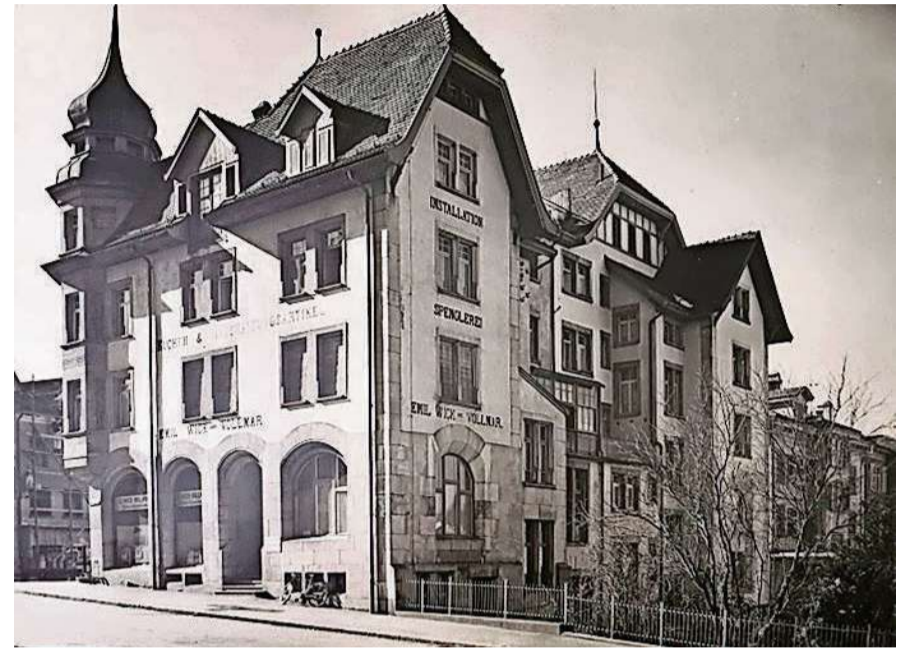
Gebäude vor dem Anbau.
