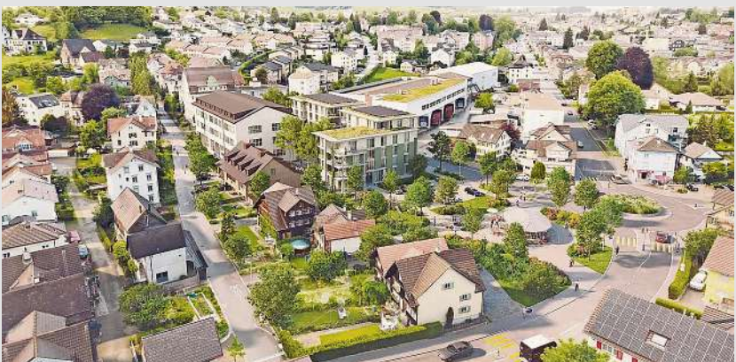
Das ehemalige Industriegebiet der Flawa präsentiert sich bald in neuem Gewand.
